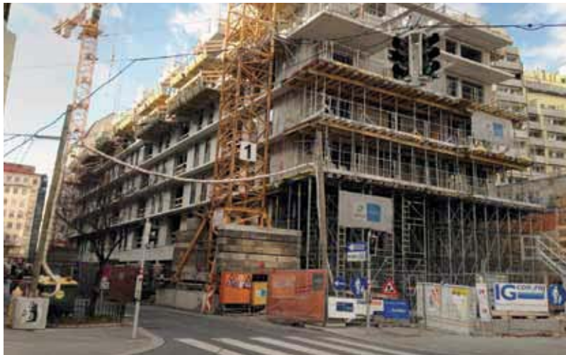
Der Rohbau in der Lindengasse soll schon heuer im Sommer fertiggestellt werden.
